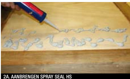
2A. AANBRENGEN SPRAY SEAL HS
