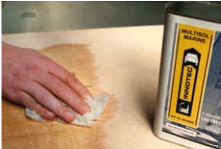
1. ONTVETTEN MET INNOTEK MULTISOL MARINE
