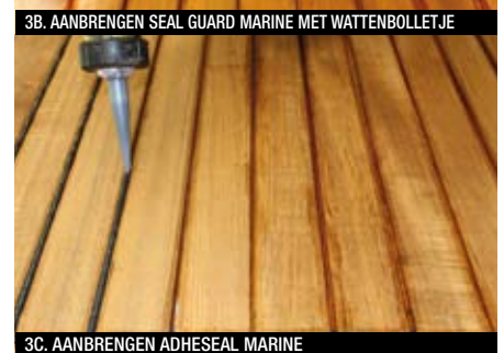
3C. AANBRENGEN ADHESEAL MARINE
